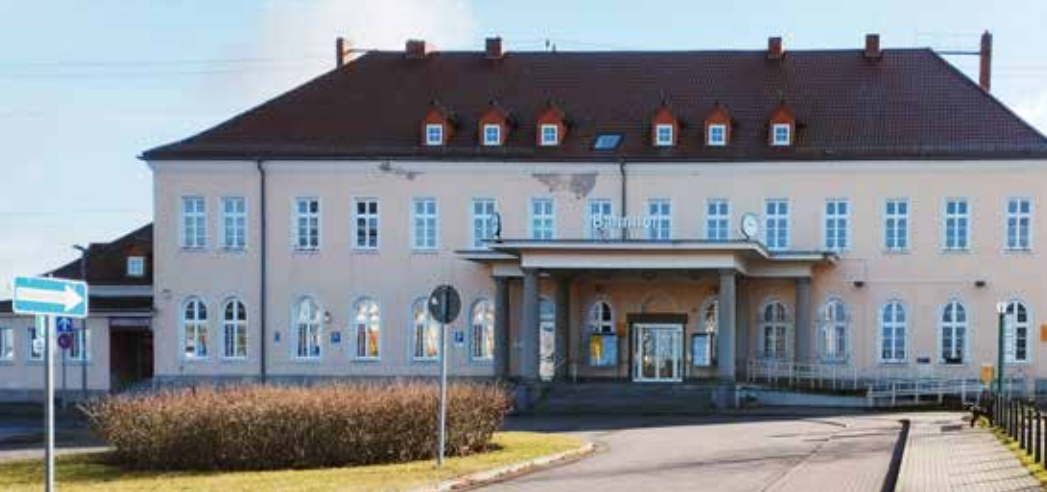
◀ Der leerstehende Bahnhof in Prenzlau soll von den „Bahnhofspionieren“ belebt werden. Foto: Stadt Prenzlau
