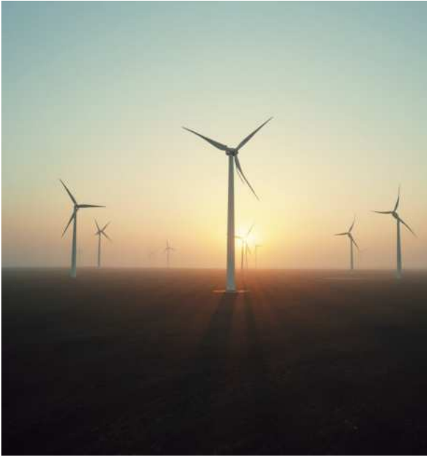
Abb. 8: Windkraftanlagen als Teil eines Windparks mit Landwirtschaftsflächen, 2024. (Quelle: INIK GmbH)
