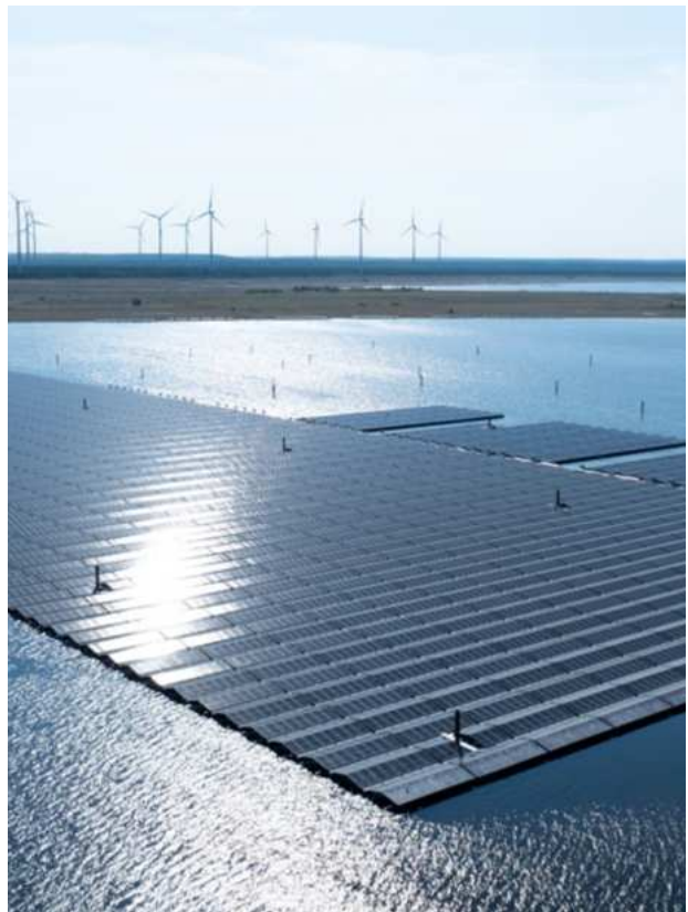
Abb. 71: Schwimmende Solaranlagen auf Tagebaufolgesee (Quelle: pvmagazine.de)
