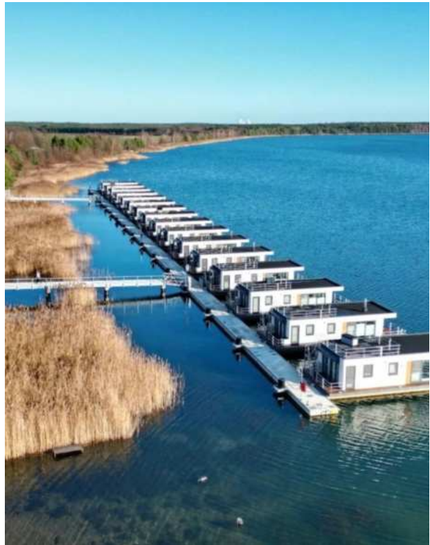
Abb. 42: Schwimmende Häuser auf dem Gräbendorfer See (Quelle: Rüdiger Hoffmann)
